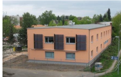
Baustraße 1 • Schwerin Bauhof SDS
