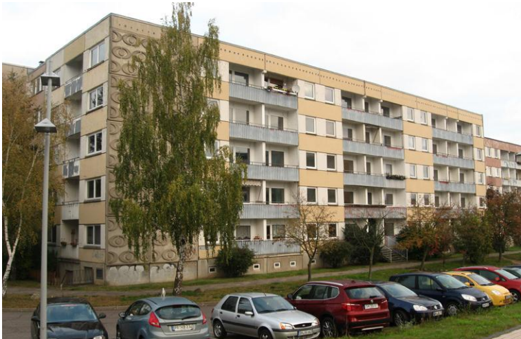
Bestand: Ansicht Straßenseite
