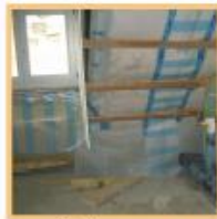
Verbesserung der Dachdämmung
