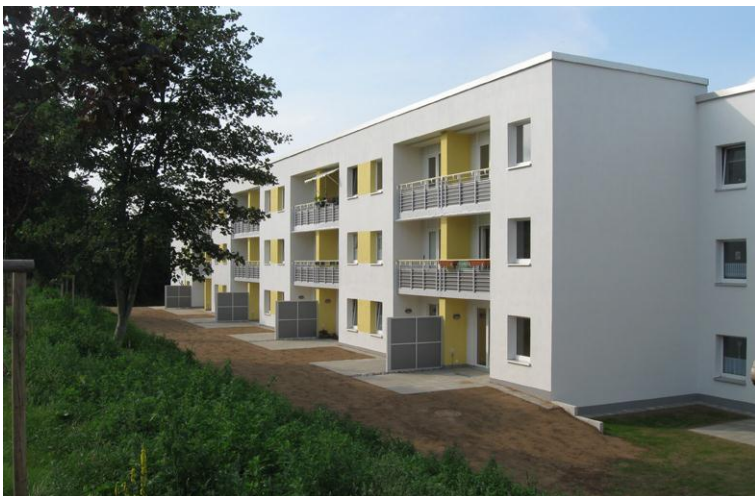
Nach der Sanierung: Ansicht Hofseite
