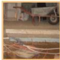
neuer Fußboden mit Fußbodenheizung
