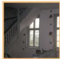
Verbesserung der Wärmedämmung bei Fachwerkwänden durch Ausblasen
