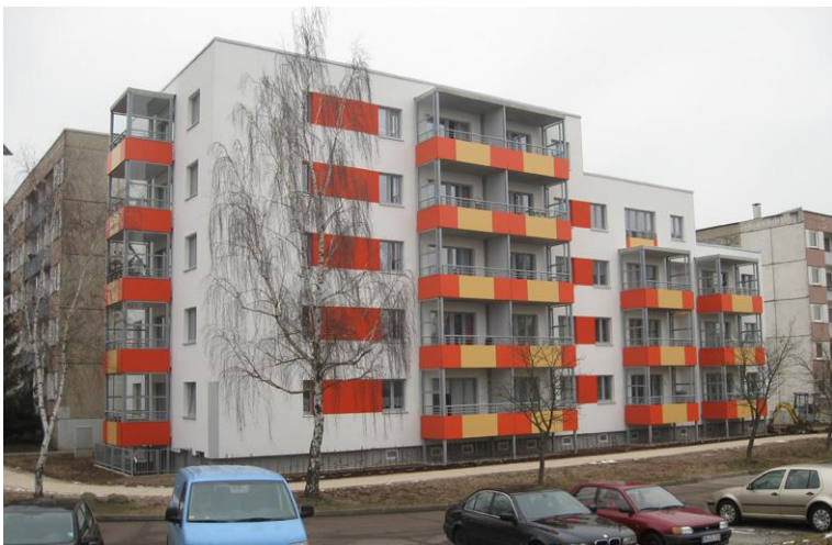
Nach der Sanierung: Ansicht Straßenseite
