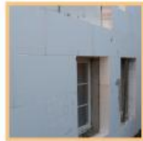
Verbesserung der Außendämmung
