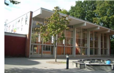
Frahmstraße 15 • Hamburg Turnhalle GS Blankenese
