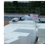
Dach- und Fuß- bodendämmung
