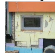
zus. Dämmung Außenwand
