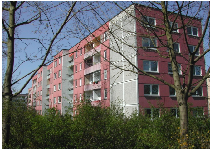
Bestand: Ansicht Balkone
