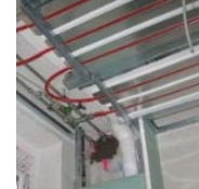
Deckenstrahl- heizung
