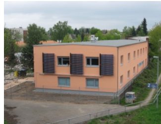
Baustraße 1 • Schwerin Bauhof SDS
