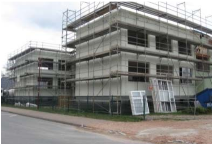
27.04.2010 Gerüst und Demontage Fenster
