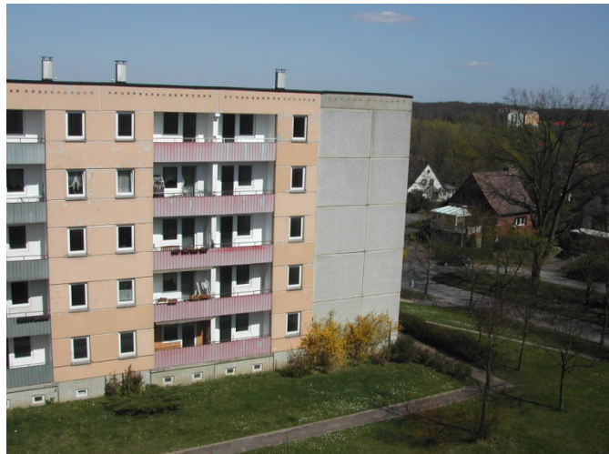
Bestand: Ansicht Balkone
