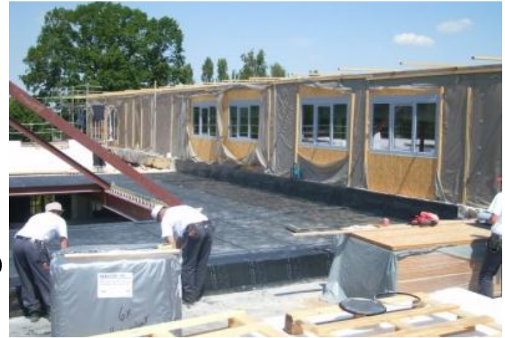
29.06.2010 Dämmung Dachfläche
