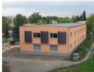
Baustraße 1 • Schwerin Bauhof SDS
