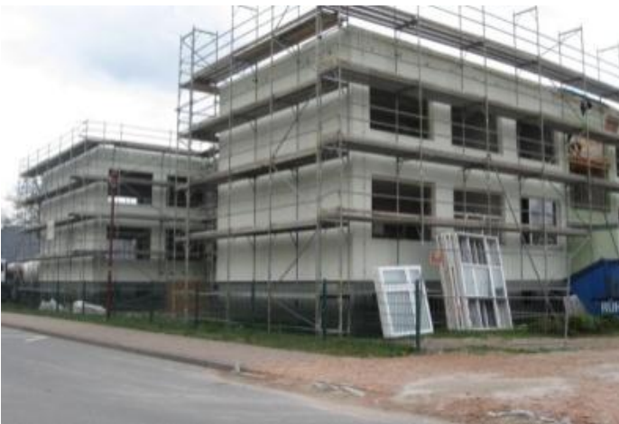
27.04.2010 Gerüst und Demontage Fenster
