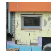
Zus. Dämmung Außenwand
