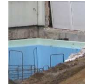
Dämmung Fuß- boden Atrium
