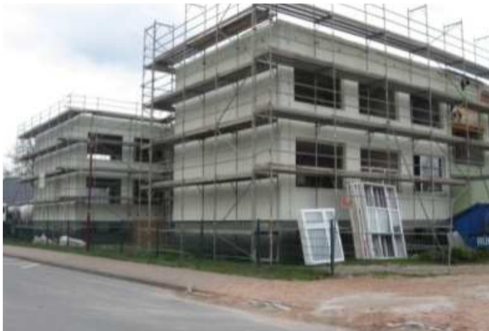
27.04.2010 Gerüst und Demontage Fenster
