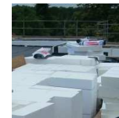
Dachdämmung
