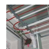
Deckenstrahl- heizung
